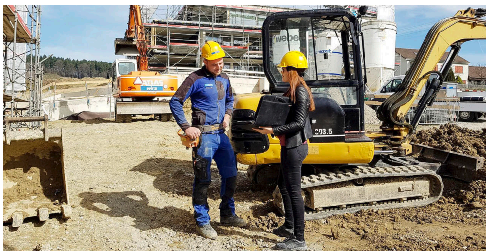
Unsere «Baustellen-Ladys» (im Bild: Ardida) werden von den Bauarbeitern akzeptiert.
